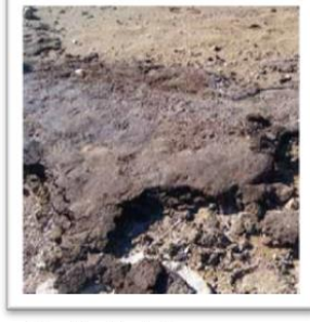
12. Asphalt Pavement (AP) OTRA
