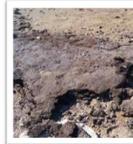
12. Asphalt Pavement (AP) OTRA
